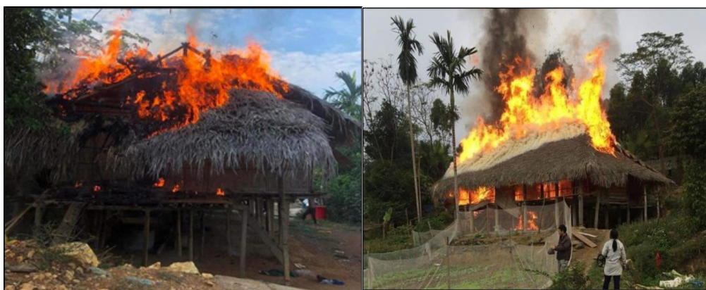
Рис. 2. Горение кровли из листьев бананового дерева
