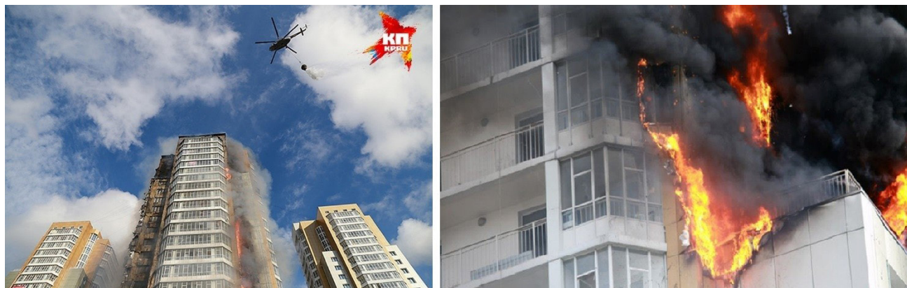
Рис. 5. Фотографии пожаров фасадных утеплителей [5]
