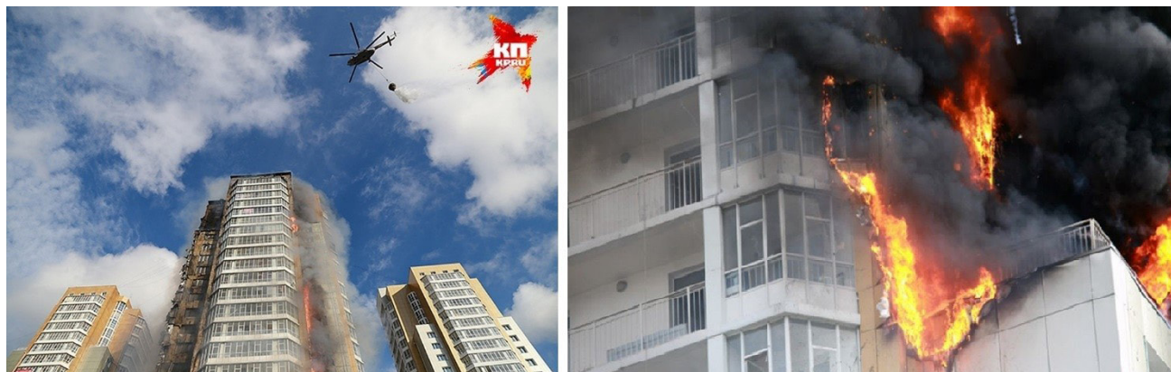
Рис. 5. Фотографии пожаров фасадных утеплителей [5]
