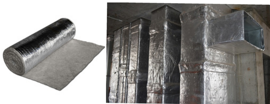
Рис. 4. Внешний вид комбинированного огнезащитного покрытия (слева) на системе вытяжной противодымной вентиляции (справа)
